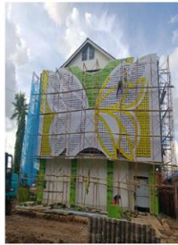
Pk. Dinding KCP Area Samping dan Lantai Seder
