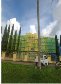
Pk. Dinding KCP Area Depan (Bekas Bangunan) dan Fening
