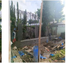
Pk. Plafond dan Acian Dinding/Fas. Batu
