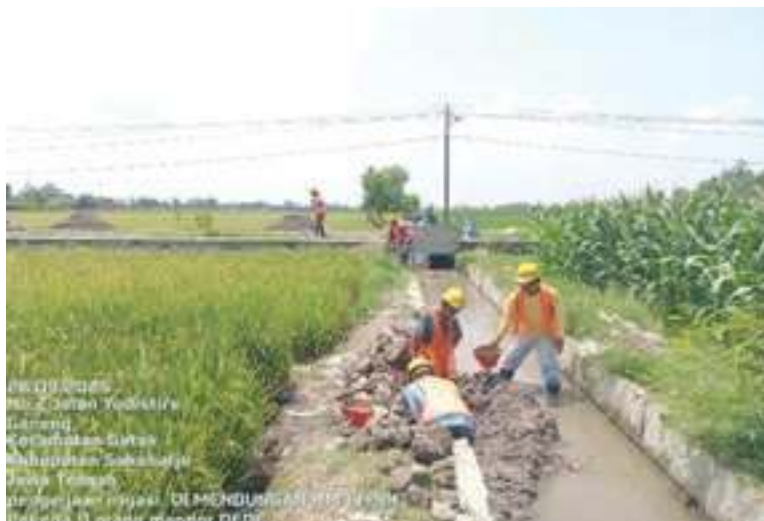
Gambar 4. 5. Perbaikan Jaringan Irigasi Tersier
