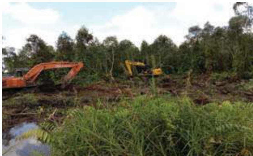
Gambar 4.4. Proses Land Clearing Pada Kegiatan Cetak Sawah
