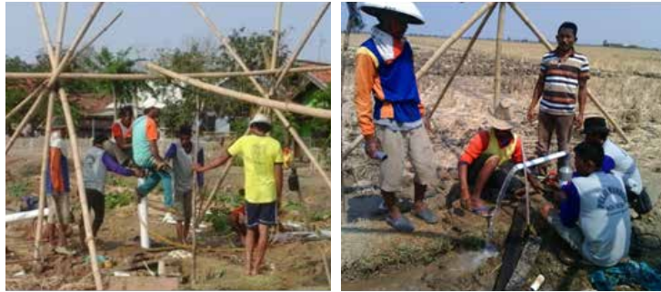
Gambar 26. Pemboran sumur air tanah dangkal dan dalam
