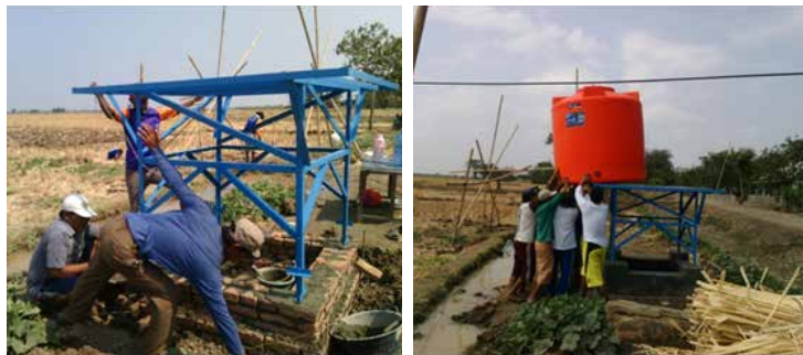
Gambar 27. Pembangunan menara air
