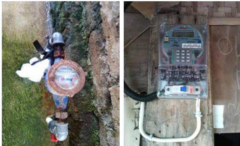
Gambar 29. Pemasangan flow meter dan kWh meter
